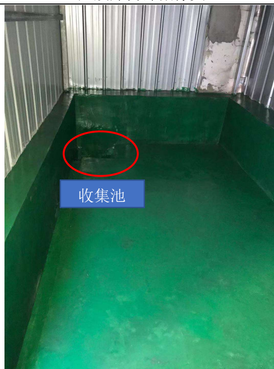
危废库地面防腐防渗+导流沟+收集池
