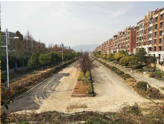
照片2 项目西侧土城头路西用地现状
