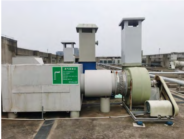
废气处理活性炭吸附装置及排气口
