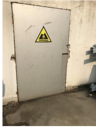
危险固废暂存库
