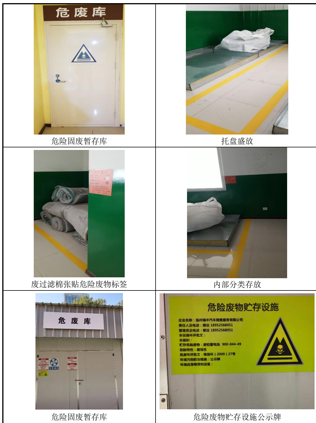
图 2.2-1 验收项目新建危废库照片
