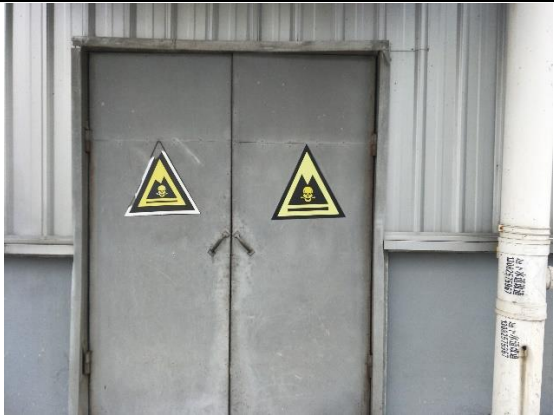
危险固废暂存库
